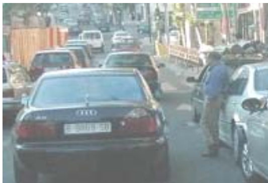
Obras y coches mal aparcados
